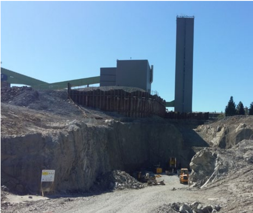
Uuden nostokuilun ja tulevan uuden nostotornin rakennustyömaa kesällä 2018. Taustalla nykyinen nostotorni ja murskaamorakennus.
