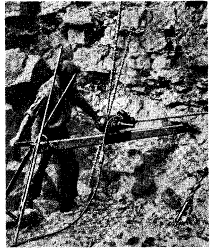
Kuva n:o 2. Sähköporausta.
