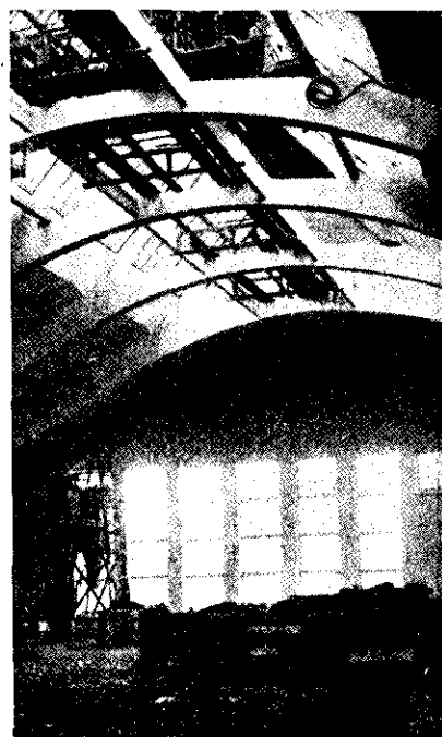
Fig. 9. Högfors nya gjuterihall (under byggnad).
