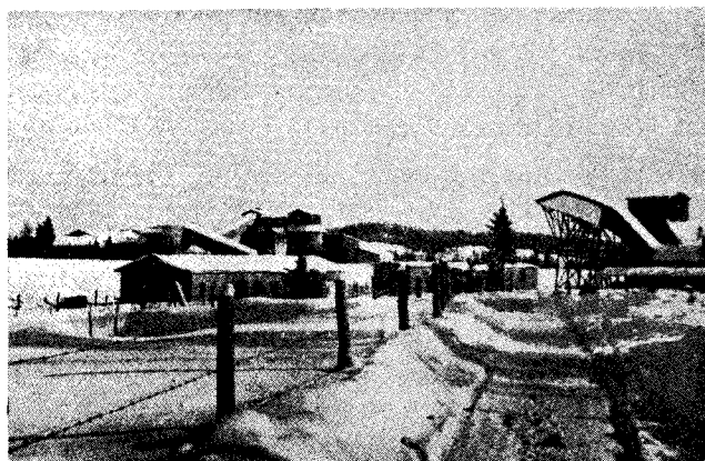
Fig. 17. Utsikt över gruvan och anrikningsverket från väster. Till höger lavarna, till vänster i förgrunden gruvstugan, bakom denna synas kross- och anrikningsverken samt i mitten gruvans maskinhus. Foto fil.mag. K. Lupander.
