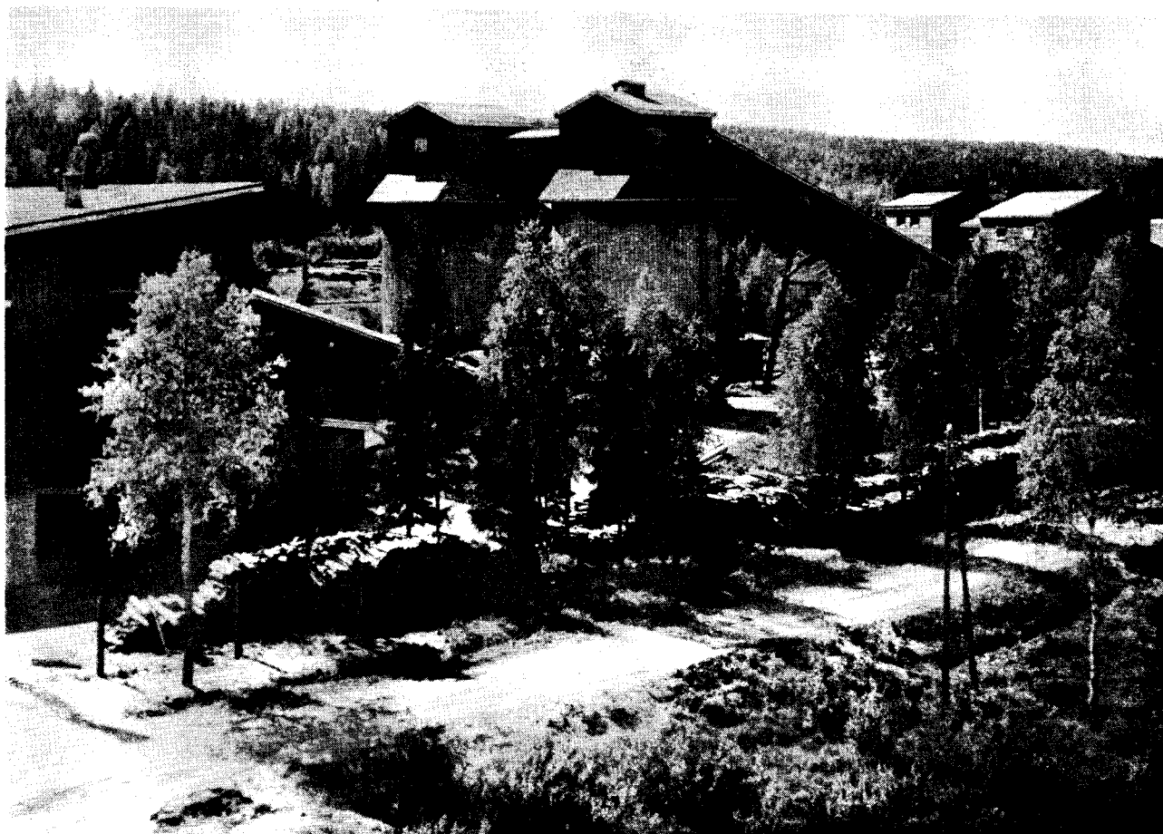
Fig. 1. En del av anläggningarna vid Mätäsvaara gruva. Till vänster synes en del av anrikningsverket (från öster), i mitten de båda betongsilona för kulkvarnsgods, till höger krossverket. — Foto fru B. Jullander.
