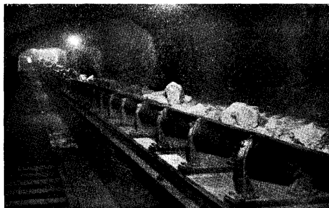
Bild 5. Bandtransportören går genom en 2,3 m×3 m tunnel i sidoberget.
