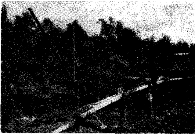
Fig. 1. Guldgrävaren Aukusti Seppänens guldvaskeri vid Kaarre- oja, vilket utgör ett gott exempel på huru guldvaskningen bedri- ves inom Lemmenjoki-området. Kaarreoja har letts i en ny fåra, som icke är synlig på bilden, och en del av dess vatten letts från en högre upp belägen fördämning i en träränna längs den gamla bäckfåran, där gruslagren vanligen är mest givande. Med den å figuren synliga handvridna kranen lyftes det ofyndiga ytskiktet upp på sidan om graven, varefter bottenskiktet gräves upp för tvättning i vaskningsrännan.
