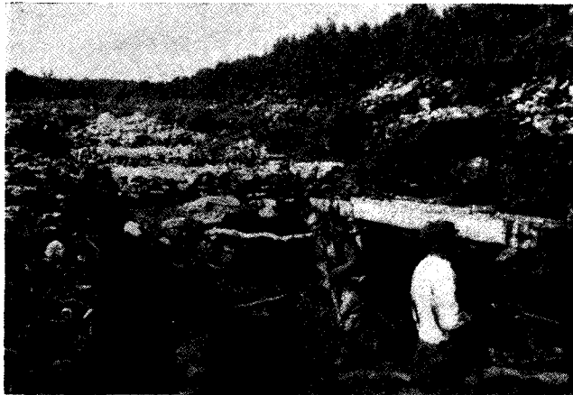
Fig. 2. Nedre ändan av samma guldvaskeri som i fig. 1. Det tvättade gruset uppsamlas i nedre ändan av vaskningsrännan bakom en med torv tätad stenbarriär. Vattnet avledes genom ett längs gravens högra sida löpande dike, som med en likadan barriär avgränsas från det tvättade gruset. Efter hand som bot- tnen på ett visst avsnitt blivit rensat och en motsvarande avfalls- bassäng fyllts med grus bygges en ny stenbarriär och arbets- platsen flyttar sig stegvis upp längs bäckfåran.
