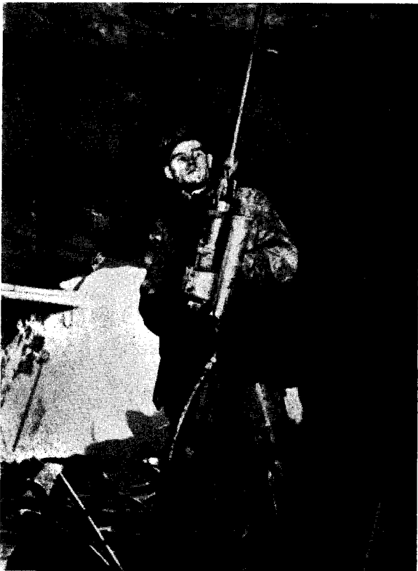
Kuva 8. Kiilakiinnitys vaihe alkamassa; lyöntipultti vielä reiän ulkopuolella; lyöntivälkappale porakoneen ja putken välissä.
