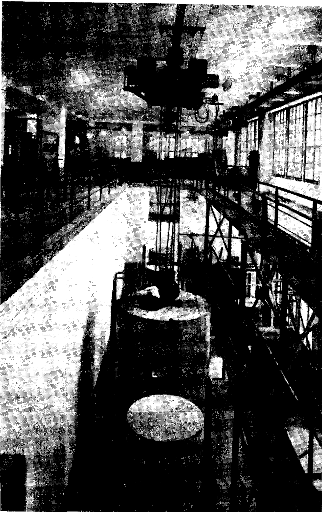
Kuva 4. Lankojen hehkutus kellouuneissa. Kuvassa näkyy kolme suojaasukupua ja nosturin alla varsinainen sähköllä lämpivä hehkutuskupu.
