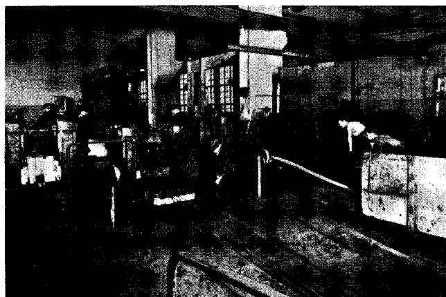
Kuva 3. Sisäkuva lankavalssilaitoksesta. Kuvassa näkyvät kolme valssituoliparia ja niitten jatkona oikealla käyttömootorin Ilgnerpyörä. Taustalla käyttökoneiston ohjaustaulut.
