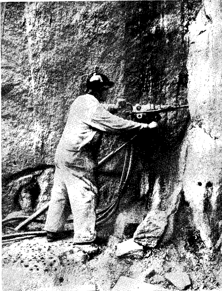
Perän poraus polvisyöttölaitteella
