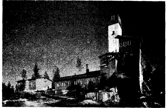
Kuva 9. Metsämontun nostotorni ja kaivostupa.
