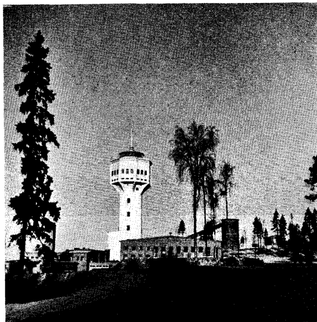
Kuva 3. Otanmäen kaivostorni lähiympäristöineen.
