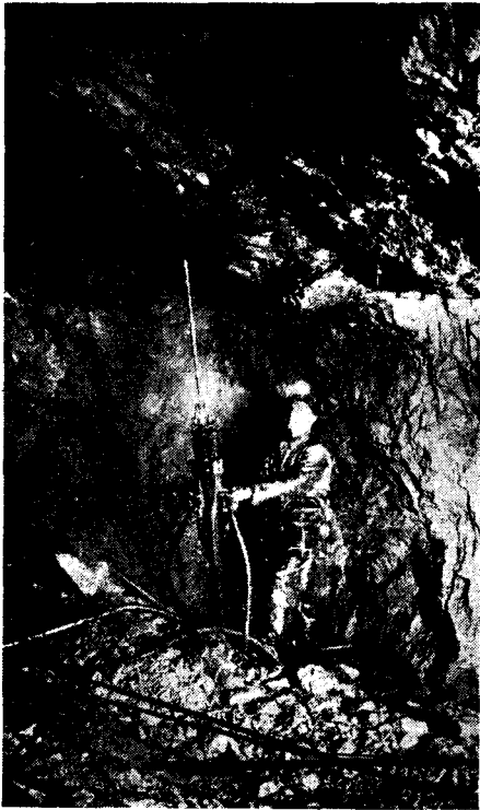
Kuva 5. Kalliopulttausporaus.
