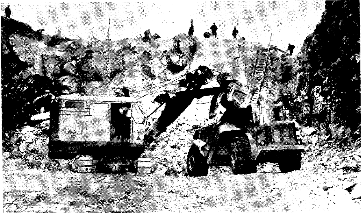
P & H malli 655 B nostamassa louhoskiveä Allis-Chalmers kivivaunuun Enso-Gutzeit Oy:n Lieksan voimalaitostyömaalla
