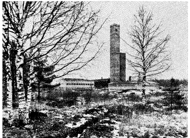
Kuva 3. Tehdasalue pohjoisesta päin. Tornista vasemmalle rikastamo ja korjaamo-varastorakennus. Etualalla konttori, jonka taakse jää kaivostupa ja voimakeskus.
