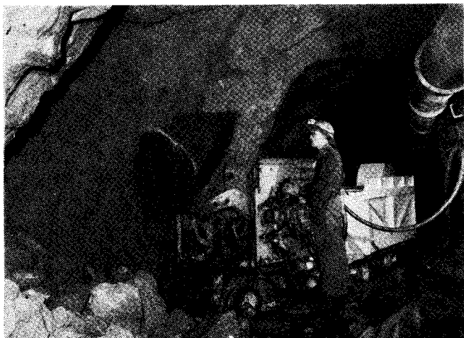
Kuva 9. Lastaus lastauskoneella paineilmakäyttöiseen keikka-vaunuun.
