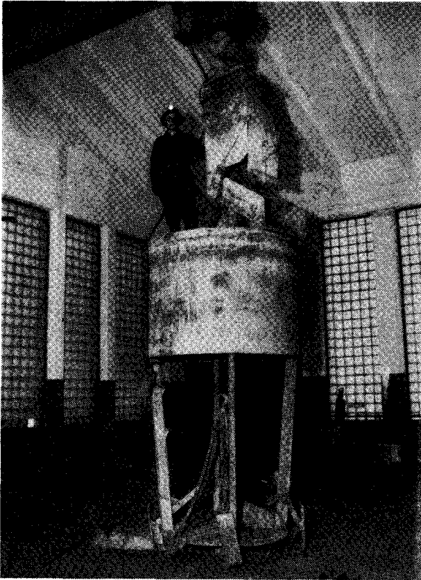
Kuva 5. Liukuvalumuotti Keretin kaivoshallissa. Ylinnä betonin laskukappa ja ohjausränni, alinna muotin ohjauskengät. Muotin alla 4 1/2 tonnin kitkatalja.
