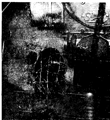
Muoviteräksen kannatus- verkko kiinnitetty aukon laitoihin porattuihin rei- kiin.
