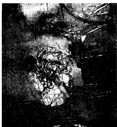
Muoviterästä levitetään verkolle käyttäen tukena paperia. Kovettumisaika 2 tuntia.
