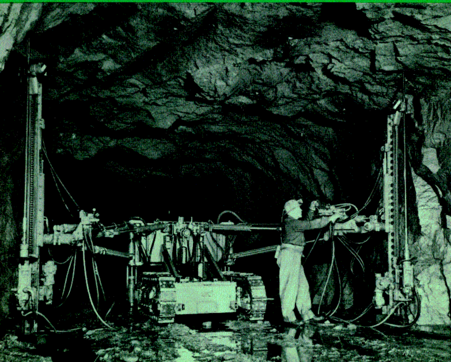
Kaksi hydraulista puomia HP 2900 asennettuna telaketjualustalle. Porakoneet S 125, syöttölaitteet KS 50.
