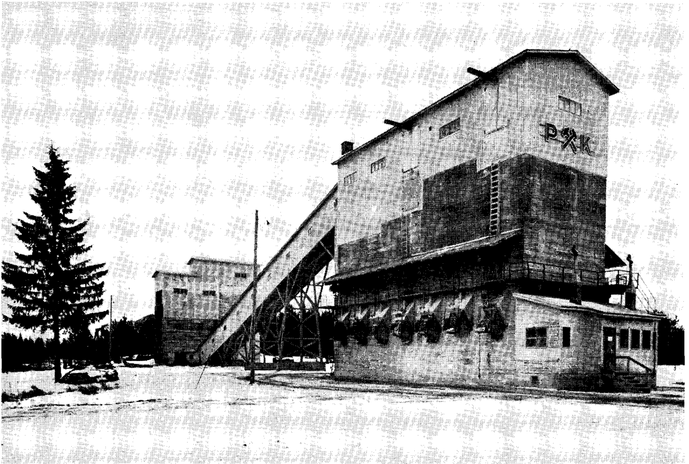
Kuva 1: Montolan kaivoksen nostotorni (taustalla) ja lajittelulaitos.
