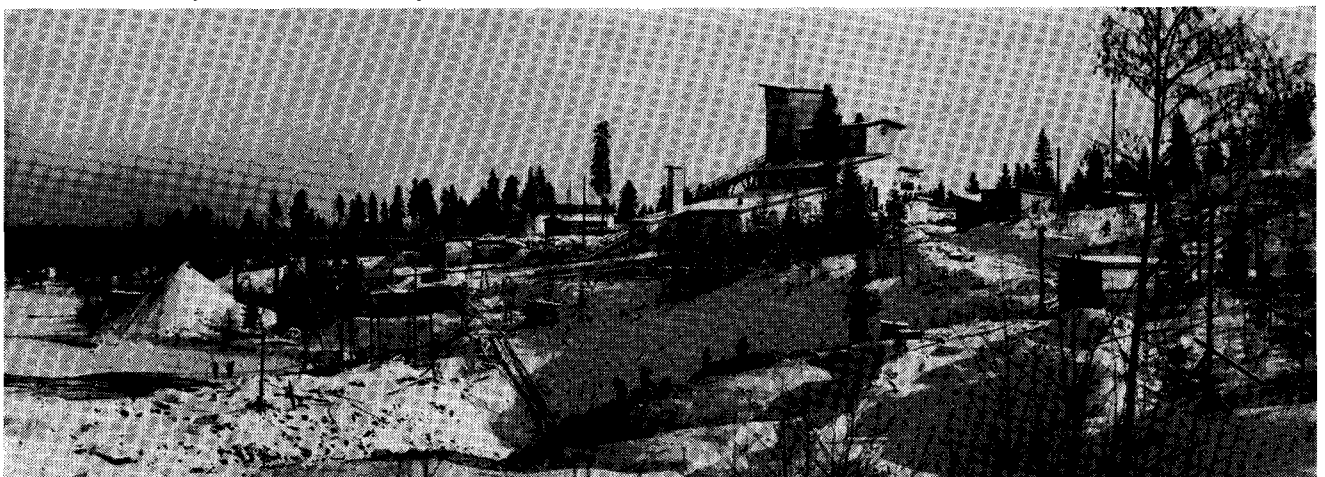
Kuva 2. Avolouhos ja rikastamo ennen laajennusta.
