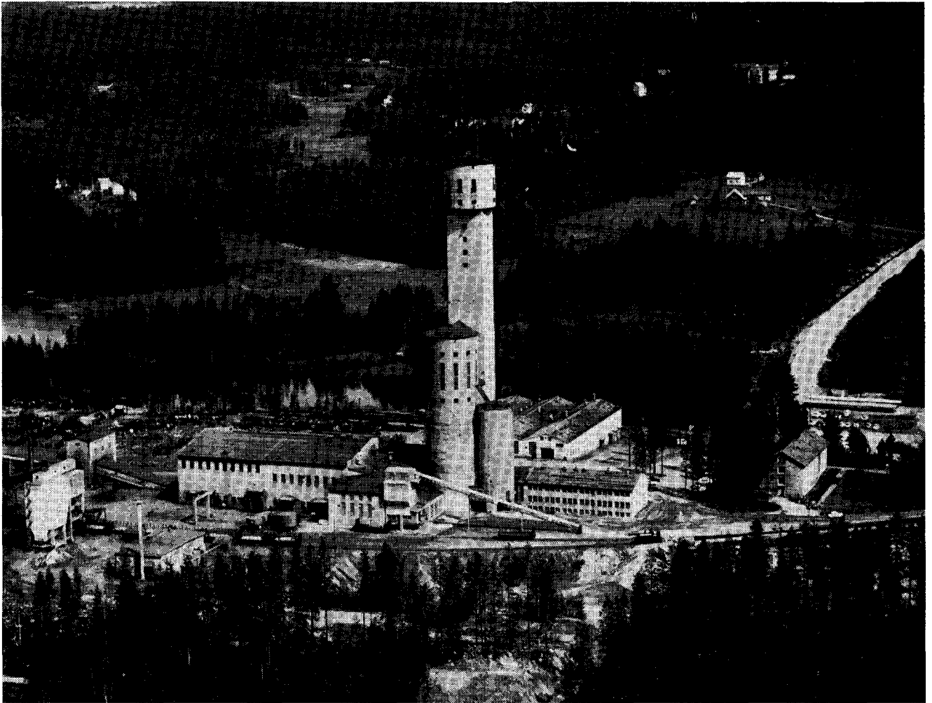
Kuva 1. Keretin nostotorni, murskaamo siiloineen ja rikastamo Outokummun kaivoksella
