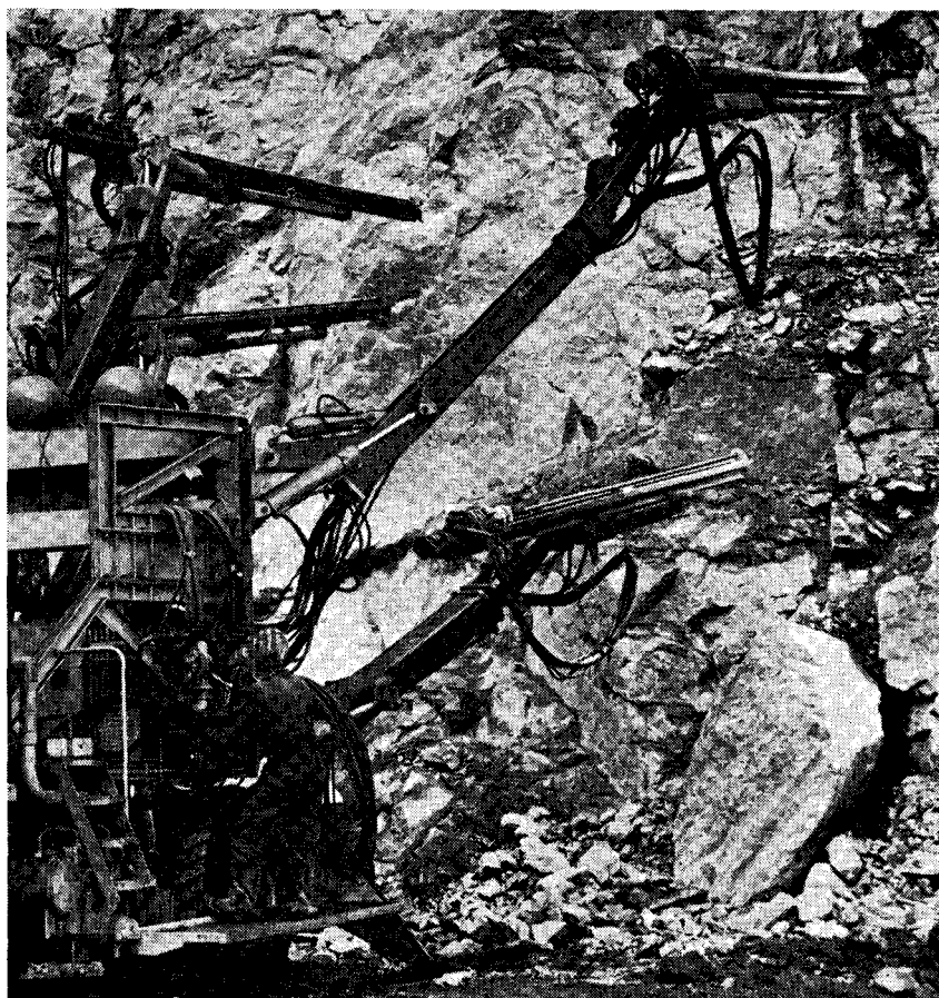
Kahden teleskooppisen puomin (yhhäällä) ja kahden "roll-over" puomin porausjumbo. Nämä neljä Atlas Copco puomia peittävät yli 100 m 2 suuruisen alueen.
