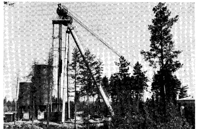
Kuva 7. Metsämontun kaivoksen teräksinen, kolmijalkainen nostotorni malmisiiloiineen Aijalassa. Se on kuten Hiturankin nostotorni siirrettävissä kaivostoiminnan loputtua toiseen paikkaan. Fig. 7. The tripod steel head frame of the Metsämonttu mine with ore silos. As also the Hitura head frame, it can be moved to another location when the mine closes.
