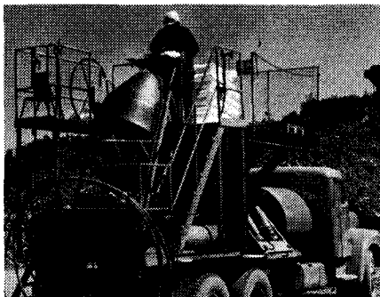
Sekoitus- ja panostusajoneuvo "Hällekis-trukki". Laitteisto on asennettu vanhan kuorma-auton alustaan, jolloin se voidaan ajaa avolouhoksen panostuspaikalle.
