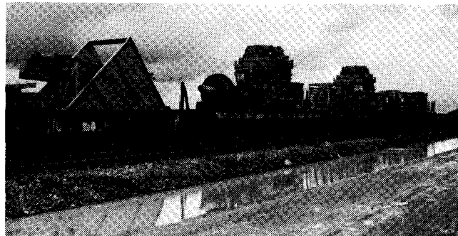
Kuva 3. Kokonainen laitos toimitettiin Liberiaan meriteitse. Buchananin satamasta se toimitettiin asennuspäikalle rautateitse ja kuorma-autoilla.
