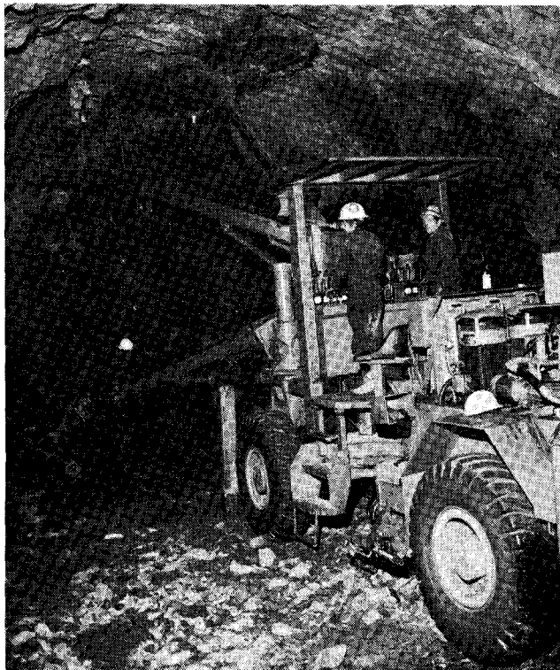
Kuva 1. Porausajoneuvo varustettuna korilla.
