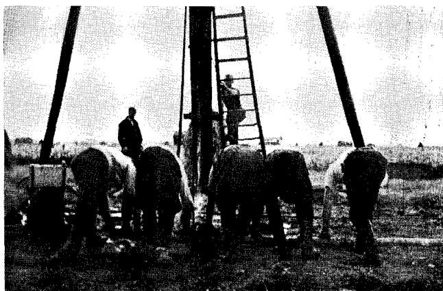
Kuva 6. Maakairaus käsijunttauksella v. 1939 Nivalan Hiturassa nykyisen Hituran kaivoksen kohdalla.
