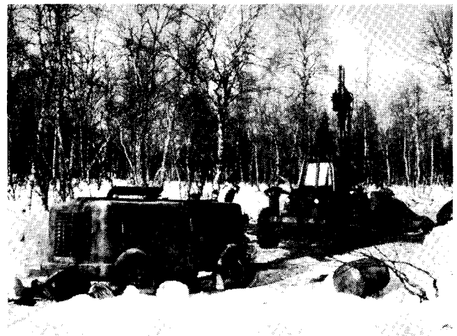
Kuva 2. Maa ja Vesi Oy:n kuivakairausyksikkö Soklin fosforimalmikairauksessa v. 1978.
