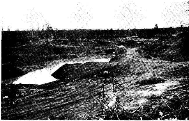
Kuva 3. Fosforimalmin avaus Loitson alueella. Malmi on irroitettu pääasiassa tutkimusrikastamon tarpeisiin.
