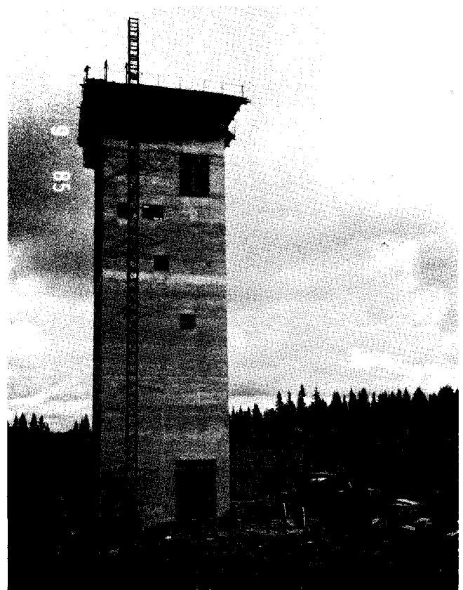
Kuva 4. Nostotornin rakennustyömaa. Liukuvalu suoritettu loppuun.
