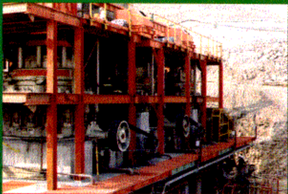
Compañía Minera Ojos del Salado S.A., Chile - instalación minera
