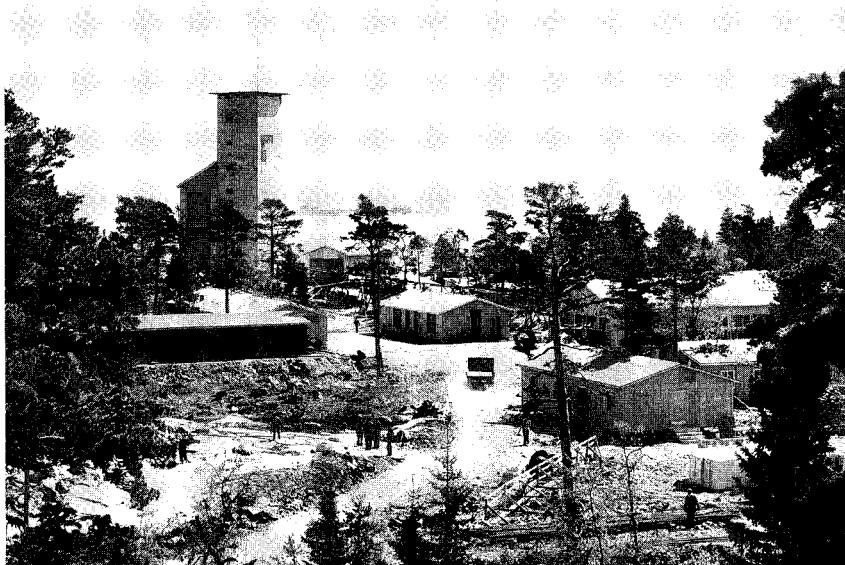
Jussarön kaivosalue, Oy Vuoksenniska Ab. Mine site at Jussarö, Oy Vuoksenniska Ab.
