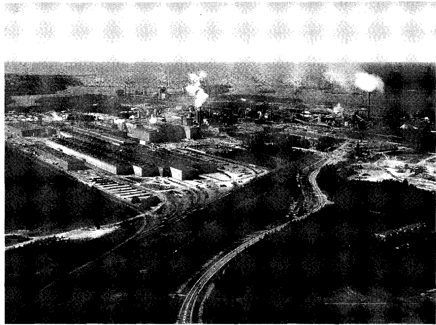
Rautaruukin teollisuusalue Raahessa, Rautaruukki Oy. Industrial area of Rautaruukki Oy in Raahes, Rautaruukki Oy.
