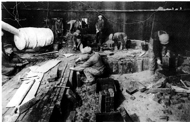
Ison sähköuunin muuraus käynnissä maaliskuun lopulla 1945.
