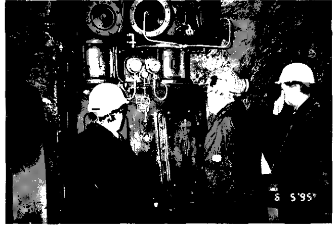
Tytyrin täysinpalvellut paineilmakompressori tarkastelun kohteena.
