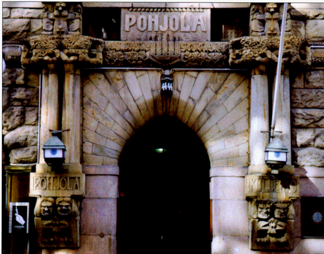
Kuva 1. Pohjola talon julkisivu Fig.1. The facade of Pohjola building.
