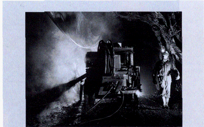
Figur 7. Ett pneumatiskt mekaniserat borrhingsaggregat. Fig. 7. A pneumatical mechanized drilling jumbo.
