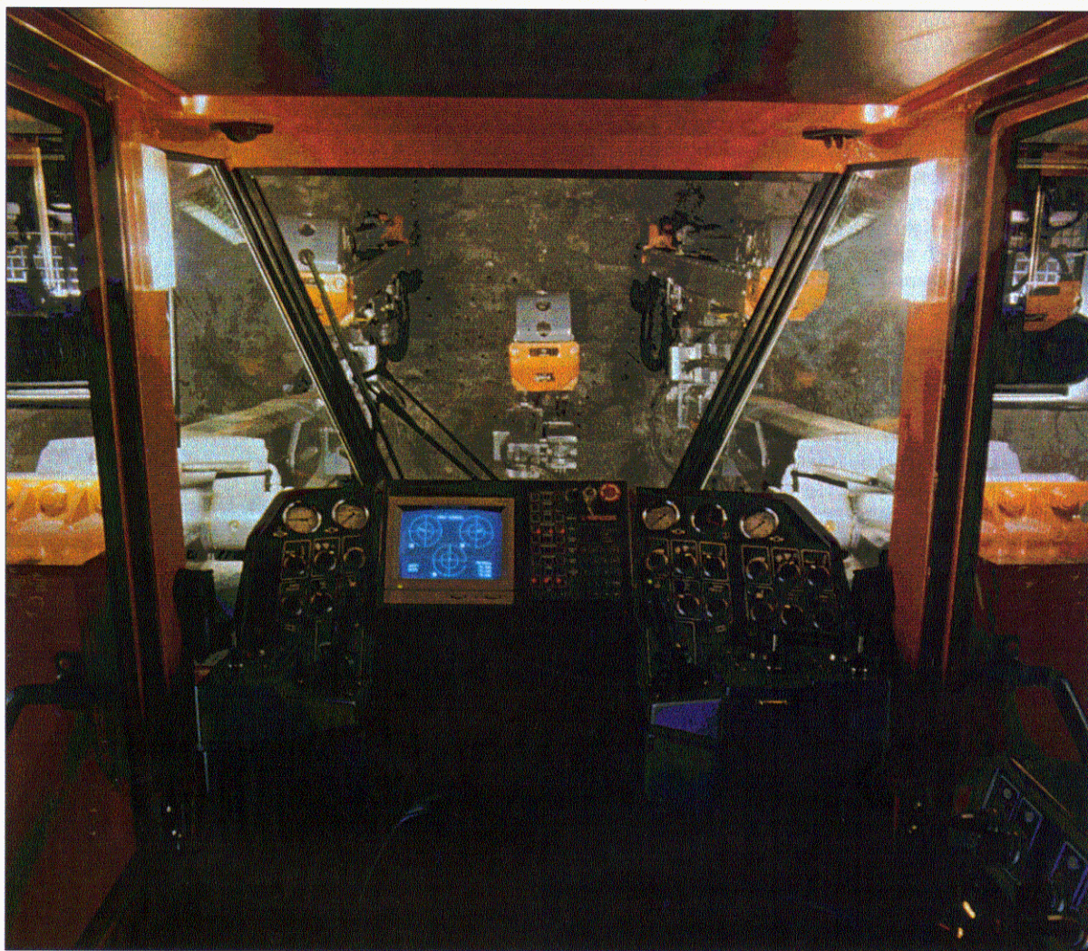
Kuva 10. Kauko-ohjattu porauslaite. / Fig. 10. A remote-controlled drilling jumbo.
