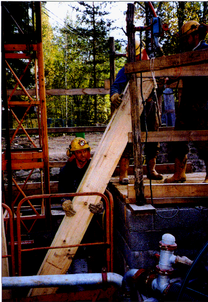
Kaivosmiehet Matti Salpakari, Antero Korhonen ja Eero Ruskee lastaavat kaivoshissiin parruja, joilla vahvistetaan kaivoskäytävien rakenteita.
