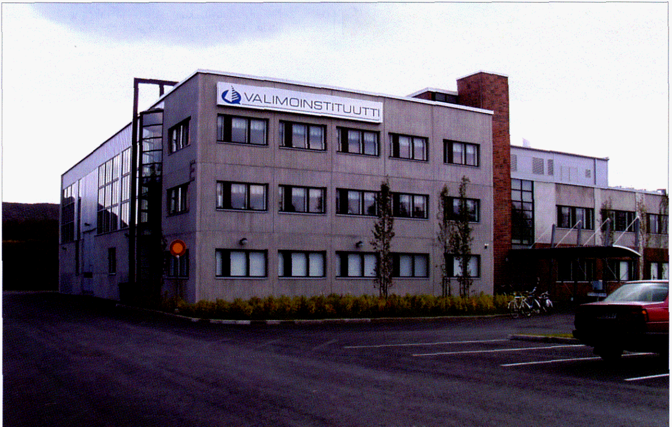
Kuva 9. Valimoinstituutin rakennuksen uusi osa.
