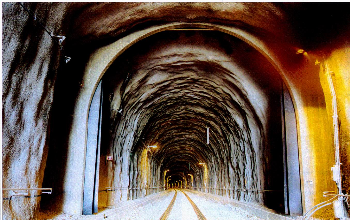
Louhintäjälkeä dataporauksella Ruotsissa. Norralan 3 850 m pitkä rautatietunneli ja lämpöovi. Syksyllä 1998.
