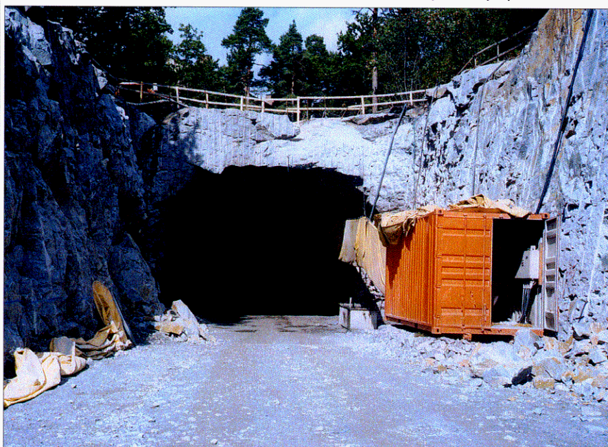
Alviks Strandin pikaraitiotietunnelin eteläinen suuaukko louhinnan jälkeen syksyllä 1998.
