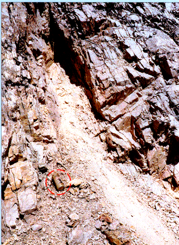
Kuva 1. Luiskasortuman aiheuttanut raparakenteinen kallio rikkonaisuusvyöhykkeessä. Mittakaavana oluttölkki. Fig 1. A road-cut slope failure caused by weathered bedrock, central Finland.
