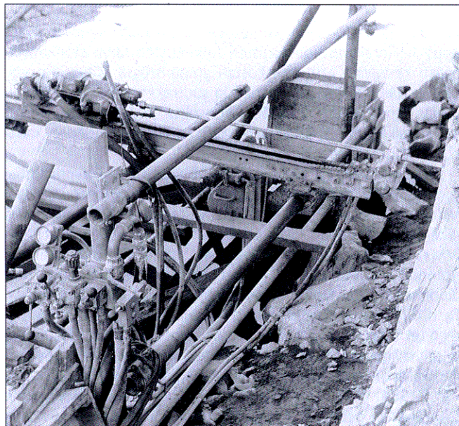
Kuva 5. Kallioluokitushankkeen porattavuustutkimuksia Vuosaaren lehtiittilouhoksessa 1972. (Foto: H. Niini). Fig 5. Arrangements for the rock borability tests in 1972 for the national engineering-geological rock classification.
