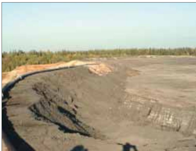
Kaivospadon korotustyö Hituran kaivoksella Nivalassa. Heightening of the tailings dam at the Hitura mine in Nivala.
