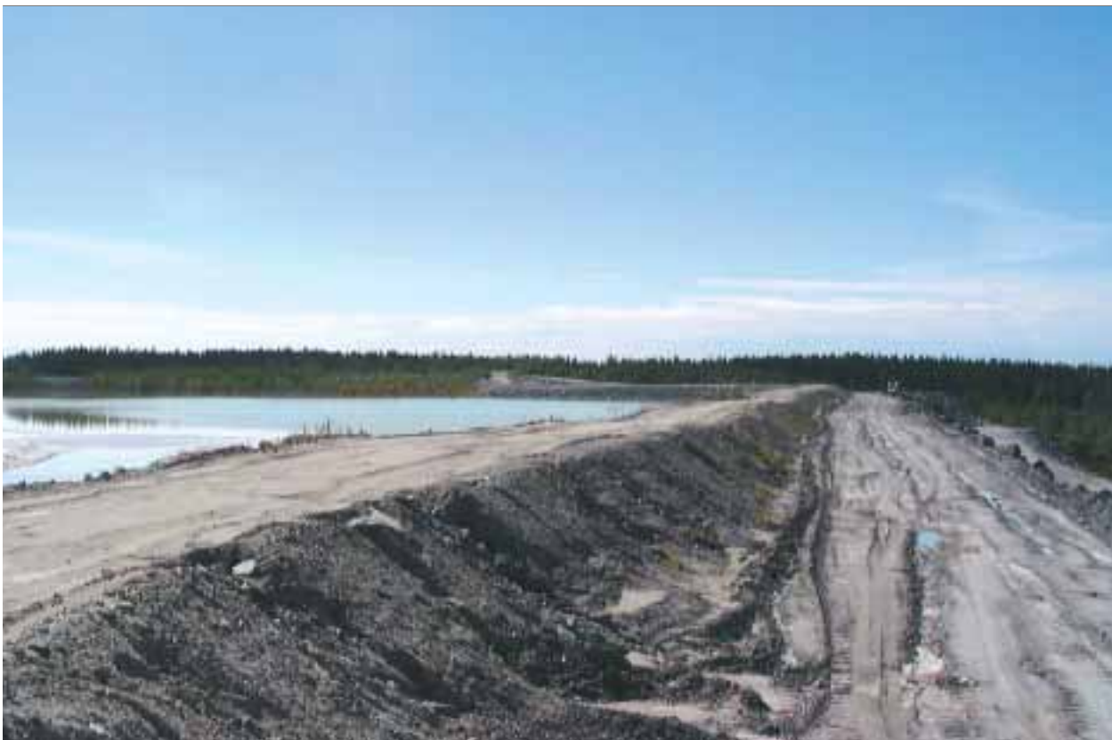
Suomen korkein kaivospato Siilinjärvellä. The highest tailings dam in Finland, located at the Siilinjärvi mine.
