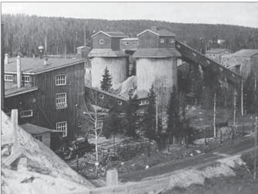
Louhinta Mätäsvaaran kaivoksella päättyi kannattamattomana vuonna 1947. Kuva kirjasta Rautainen leipäpuu.
