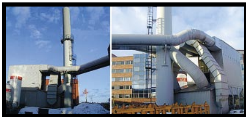
Kuva 2. Moderni sulatushuurujen ja -pölyjen kuiva-suodatuslaitos.
