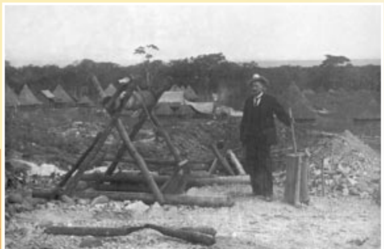
Oskar Boijer Kansanshiin kaivosrakennellessa.
