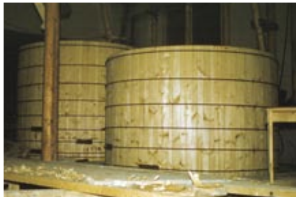
Rikastusprosessin liuotusaltaita. Tammikuu 1960. Kuva Kalervo Räisänen.
