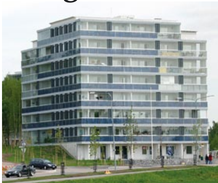
Kuva B. Rakennukseen integroidut 24 kW p aurinkopaneelit osana kerrostalon parvekekaidetta Helsingin Ekoviikissä. Kuva: NAPS Systems Oy, © Ilkka Pohjanpalo.
