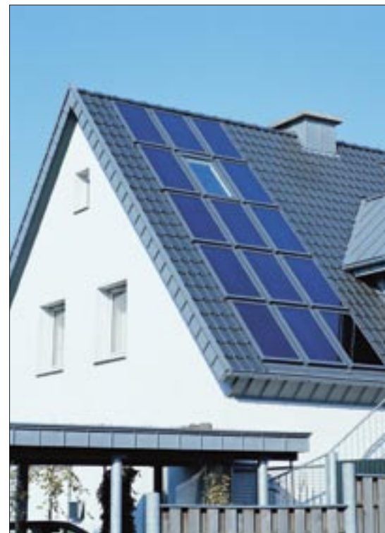
Kuva G. Euroopassa yleisin lämpökeräintyyppi on tasokeräin ja Kiinassa tyhjöputkikeräin. Nämä kuvat ovat Saksasta, kuvien © VELUX ja SCHOTT-Rohrglas / ESTIF
