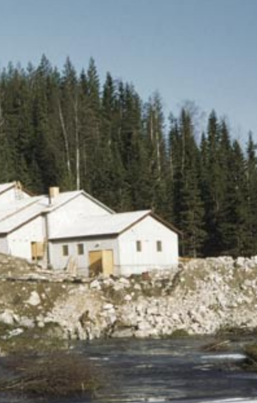
Paukkajavaaran uraani-kaivoksen rikastamo tammikuussa 1960. Suunnittelussa oli käytetty hyväksi maaston sopivan kaltevaa rinnettä. Syötetty malmi siirtyi painovoimalla vaiheesta toiseen yksinkertaisin laittein. Kuva Kalervo Räsänen.
