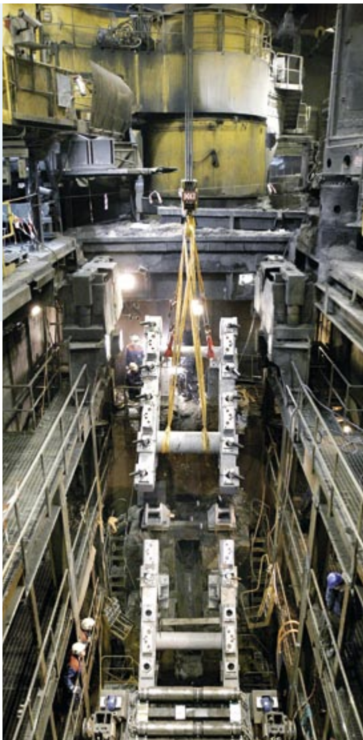
Fundamentet till den nya gjutbågen under montering.
