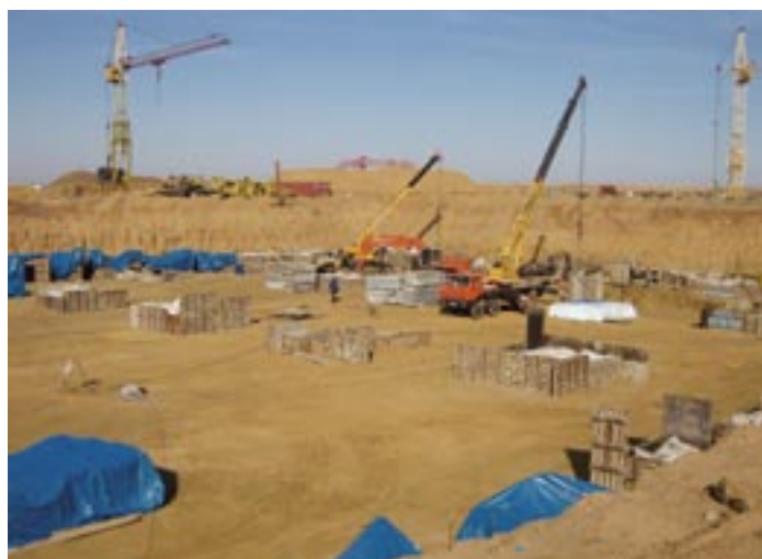
Koktaun uuden kupari-sinkki-rikastamon rakennustyömaa syksyllä 2006.
