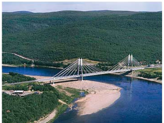
Kuva 4. Utsjoen Saamen silta, valmistettu lujuusluokan 420 MPa TM-teräksestä.
