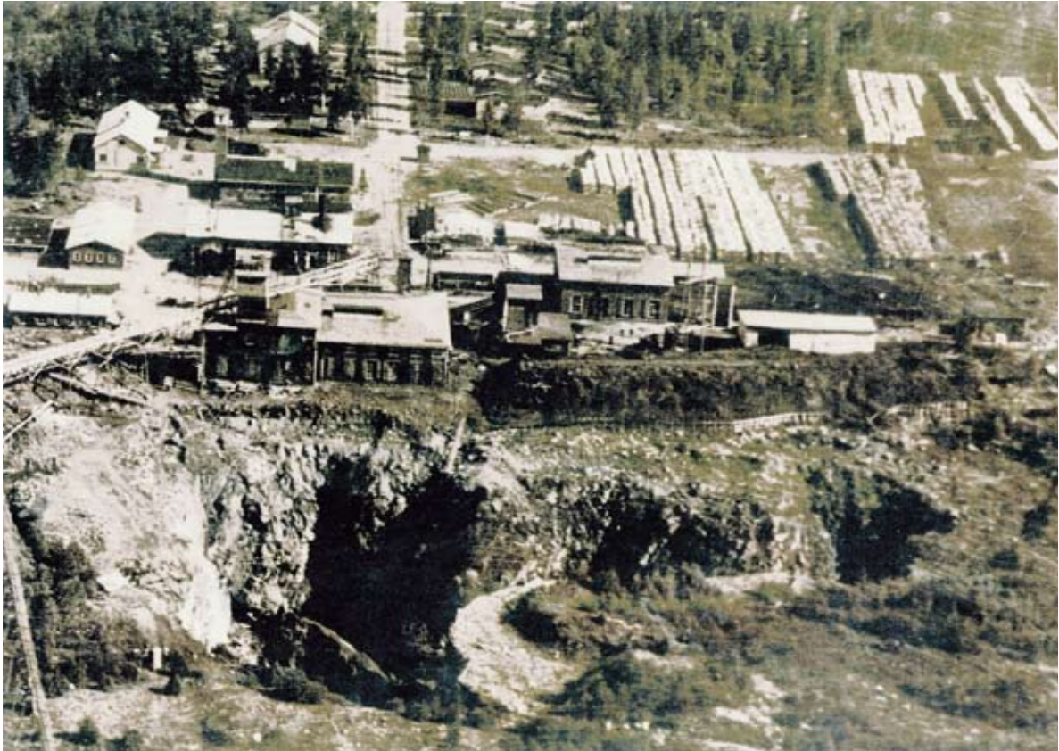
Kuva 6. Makolan kaivosalue 1940-luvulla: etualalla avolouhos, jonka takana nostotorni ja tuotantolaitokset, taaempänä Makolaan johtava tie ja kaivosalueen sekä kaivoskylän rakennuksia. Osa kuvasta Hituran kaivoksen arkistossa.
