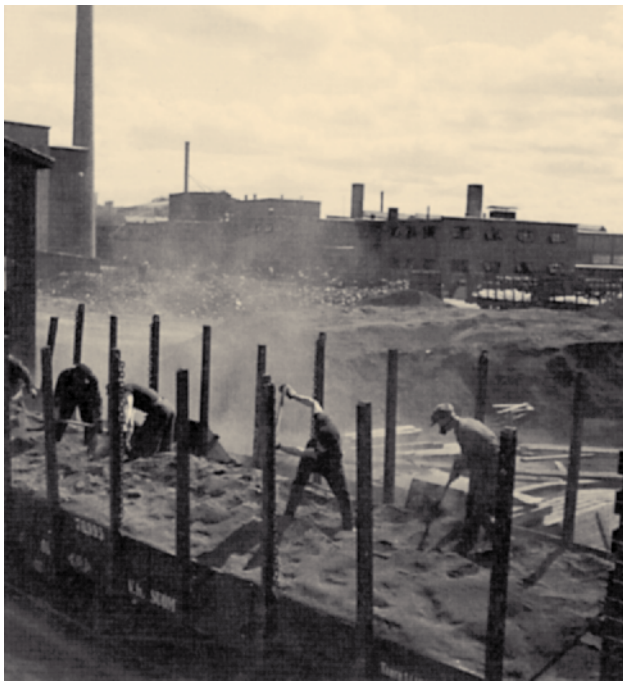
Kiisutuhkan purkaus. – Hienojakaisen ja kii- vänä runsaasti pölyävän kiisutuhkan lapiointi oli likaista työtä. Tuolloin ei työsuojelulainsäädäntöä vielä ollut, mutta vuori- neuvos Grönblom tun- netusti pyrki pitämään työntekijöistään hyvää huolta. Jos lääkärintutki- muksissa havaittiin pölyä keuhkoissa, mies vaih- dettiin toisiin tehtäviin. Muissakin kobolttiteh- taan työvaiheissa oli vaikeita työolosuhteita ja käsiteltiin vaarallisia ke- mikaaleja. Saarnin haas- tattelemien kobolttiteh- taan entisten työntekijöiden ja työnjohtajien mukaan vakavia terveyshaittoja ei kuitenkaan kenellekään tullut.
