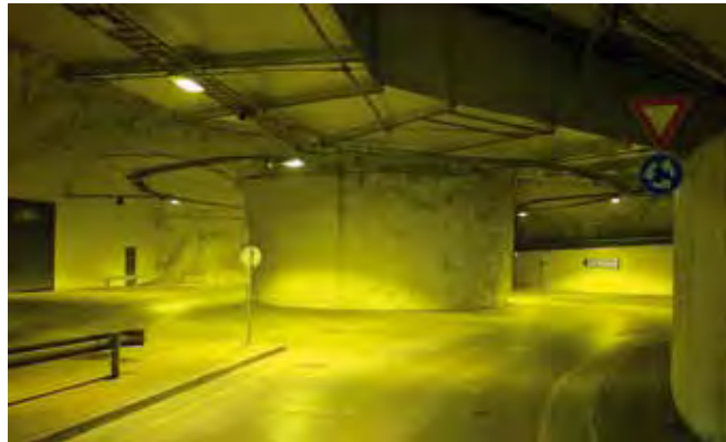
Tietunnelissa oleva liikennempyörä. Keskustan huoltotunneli (KEHU).
