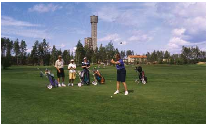
Tämän verran on jäljellä Keretin kaivoksesta, joka suljettiin 1987. Nostotorni näkyy yli horisontin ajoitpa 'kumpuun' mistä suunnasta tahansa. Ja muistuttaa innovaatiosta, painovoima on valjastettu korvaamaan malminkäsittelyn kuljettimet. Keksintö keräsi huomiota ja vierailuja kaikkialta kaivosmaailmasta. Vanha rikastushiekka-alue on maisemoitu golfkentän alle.
