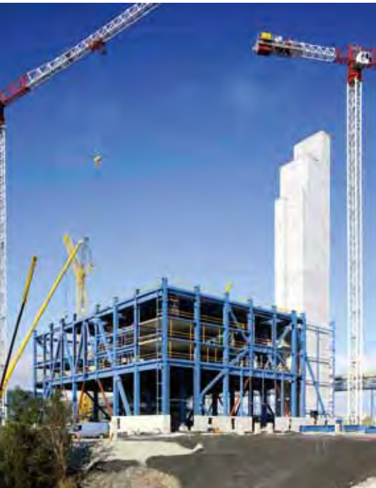
Kuva 1. FeCr-sulaton rakennustyömaa syyskuussa 2011.
