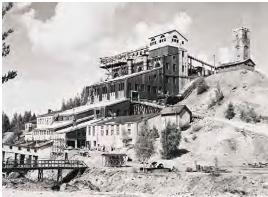
Museorakennus ja vuosiluovulla 1927 leimattu portaali näkyvät sivulla 74, ovat Vanhan rikastamon takana. Rinnerikastamoratkaaisu kertoo miten rikastusprosessi on järjestetty lähes ilman lietteen pumppausta painovoimalla. Koneet ja laitteet on sijoitettu turistireitin varrelle selostuksineen.
