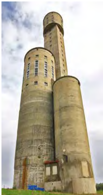
Tämän verran on jäljellä Keretin kaivoksesta, joka suljettiin 1987. Nostotorni näkyy yli horisontin ajoitpa 'kumpuun' mistä suunnasta tahansa. Ja muistuttaa innovaatiosta, painovoima on valjastettu korvaamaan malminkäsittelyn kuljettimet. Keksintö keräsi huomiota ja vierailuja kaikkialta kaivosmaailmasta. Vanha rikastushiekka-alue on maisemoitu golfkentän alle.
