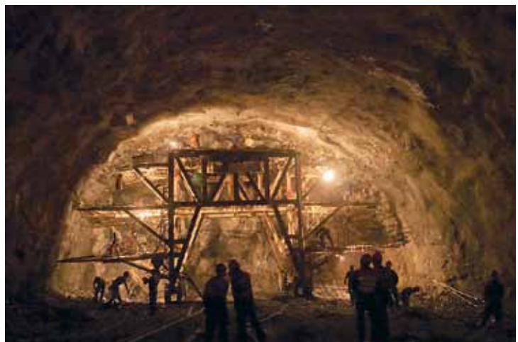
Kuva. Ns. Gantry-alusta, jonka päältä porataan käsikoneilla ja suoritetaan muita tunnelinrakentamisen työvaiheita.
