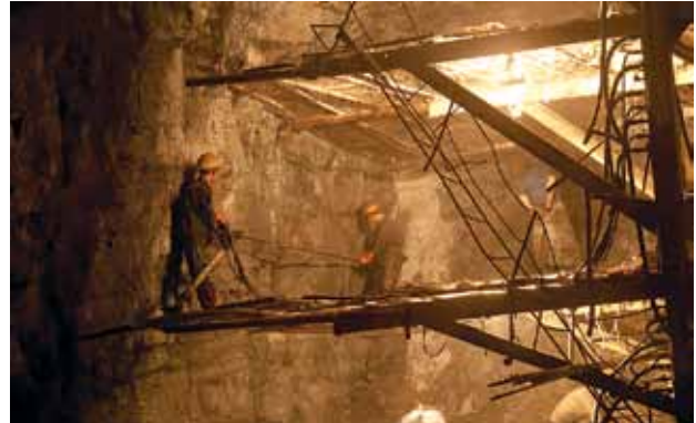
Käsi-poraus käynnissä Gantry-alustalla.
