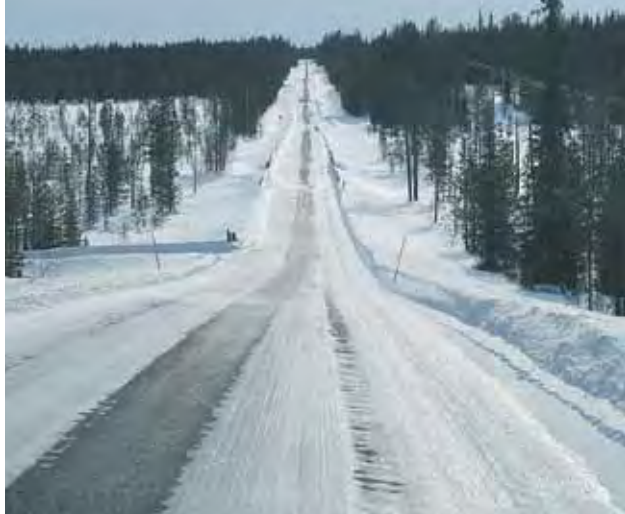
Tie 9401 Muotkavaara – Äkäslompolo. Kuva LF
