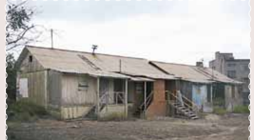
Pientaloja on muutettu ja niihin on rakennettu lisäosia, mutta kivijalka, rakennuksen runko, katto-kulma, ikkuna-aukotus ja ulkovooraus muistuttavat suomalaisajasta.
